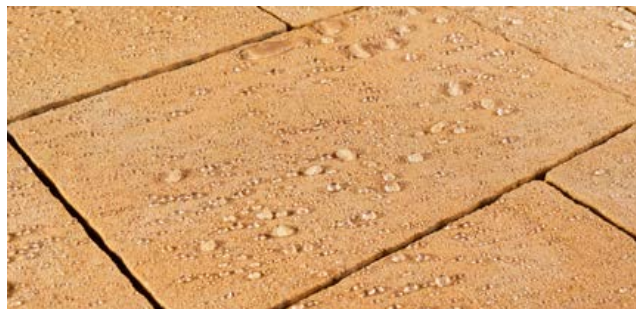
POVRCH DLAŽBY S ÚPRAVOU DEP
