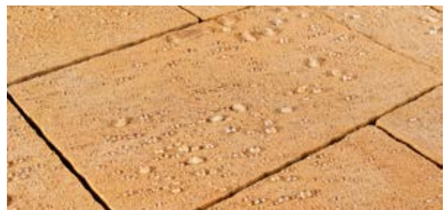
POVRCH DLAŽBY S ÚPRAVOU DEP
