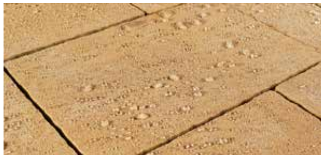
POVRCH DLAŽBY S ÚPRAVOU DEP
